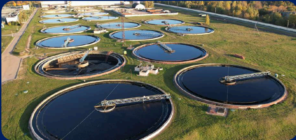
Plantas de tratamiento de agua
