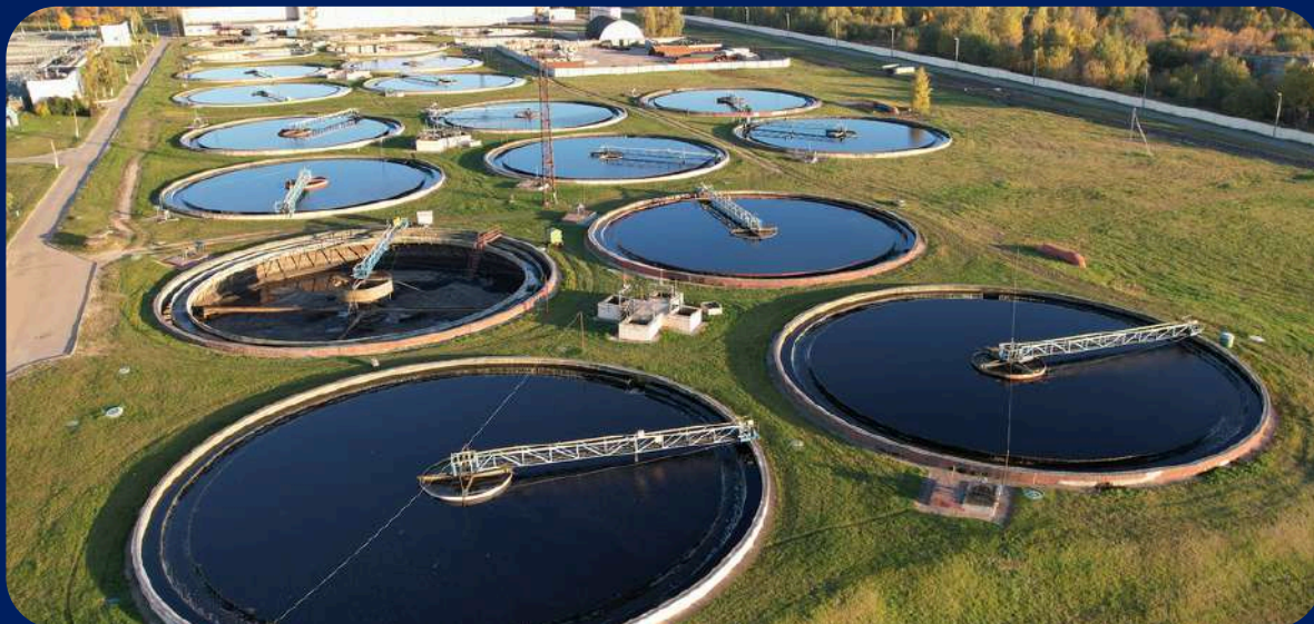
Plantas de tratamiento de agua
